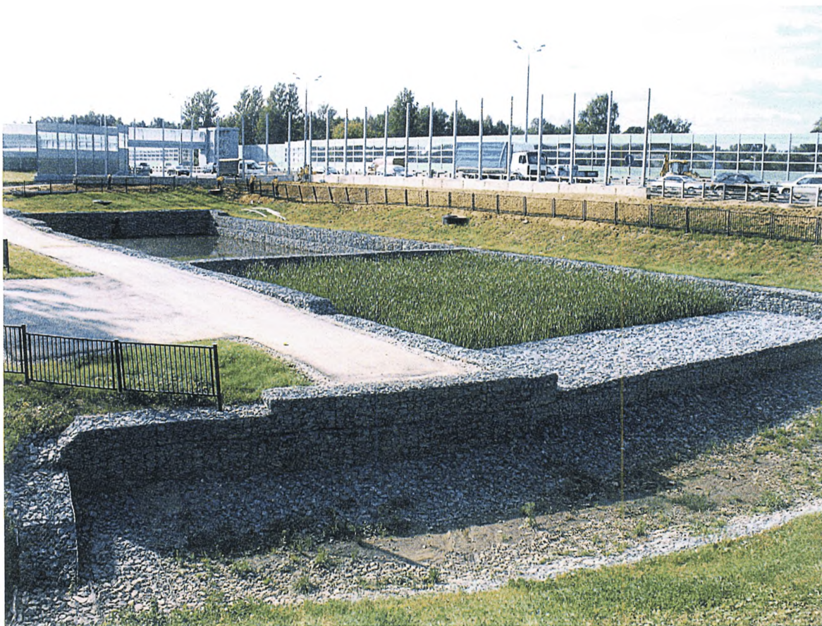
Рис. 4.1.5. Очистное сооружение каскадного типа с использованием габионов (вид сбоку)
