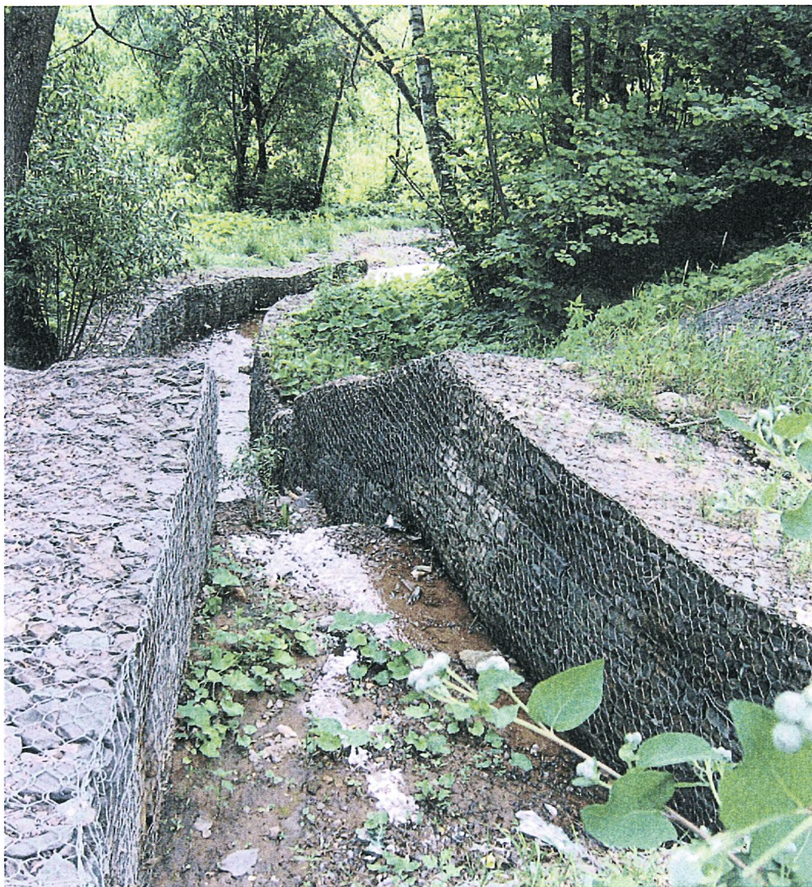
Рис. 4.6.5. Лоток сброса очищенных стоков на рельеф местности
