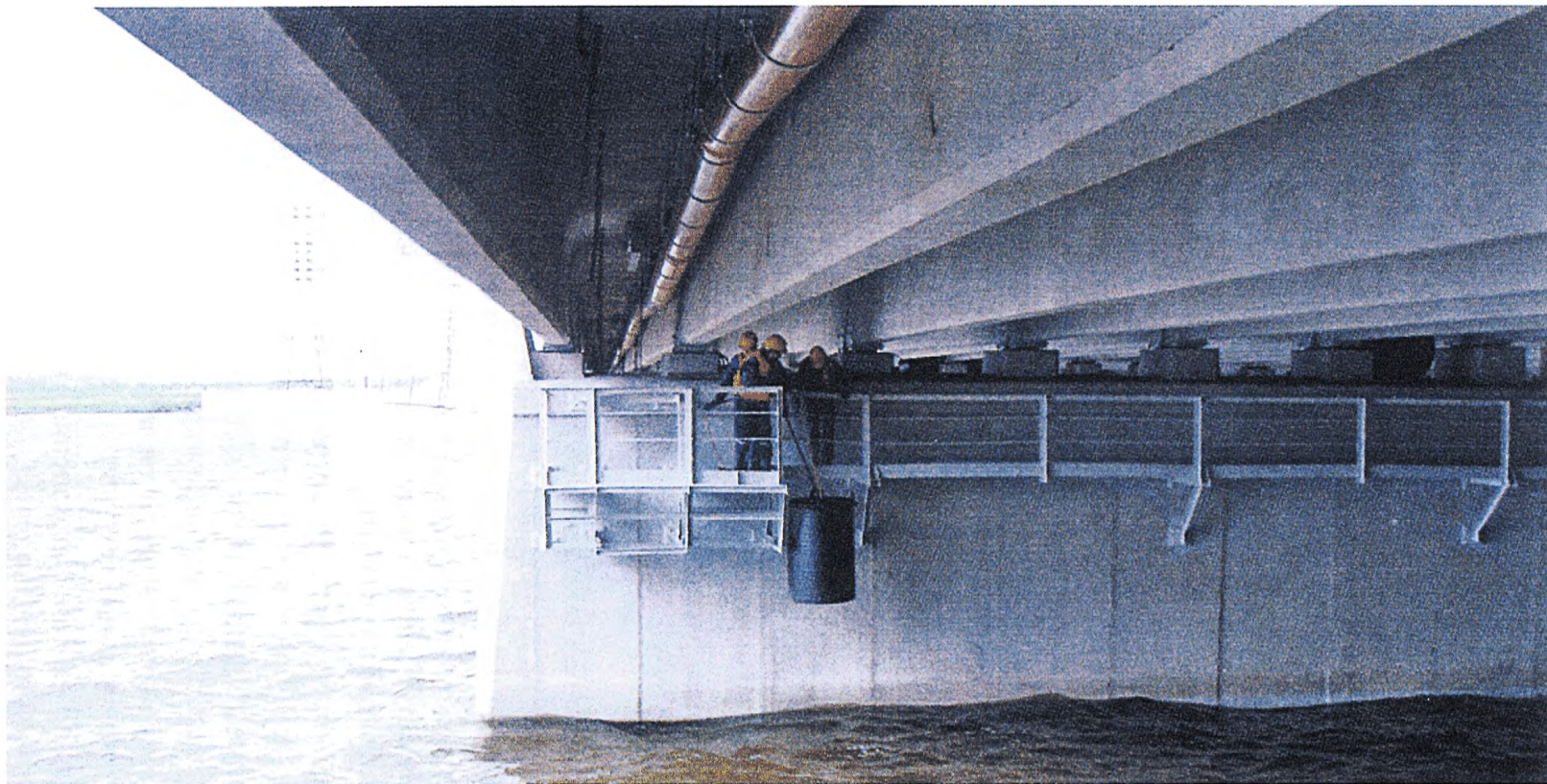
Рис.4.7.3. Комбинированный фильтрующий патрон (установка на опоре моста)
