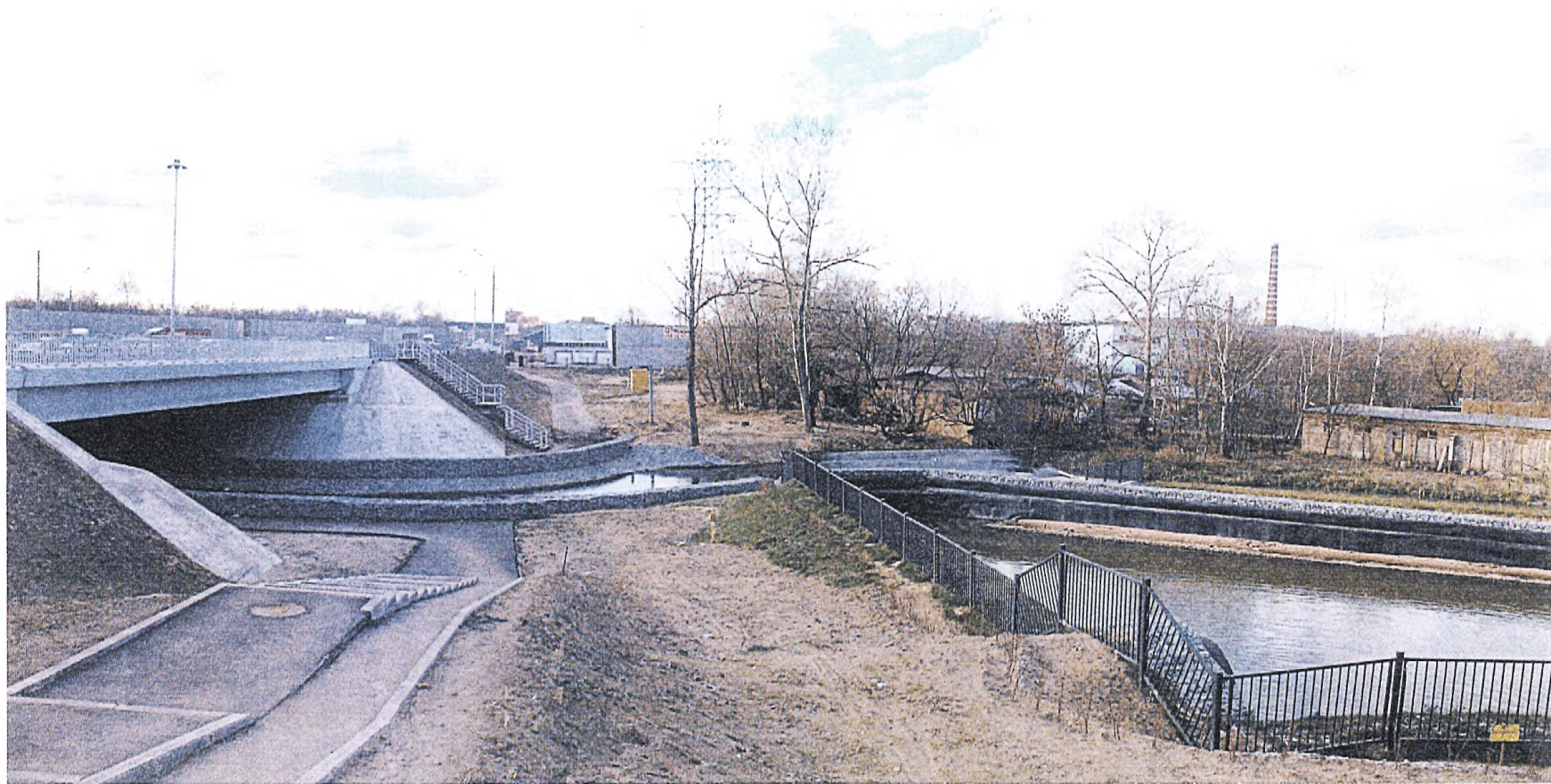
Рис. 4.1.8. Очистное сооружение (пруд-отстойник каскадного типа)
