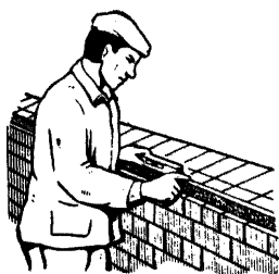
Рис. 32. Проверка горизонтальности ряда кладки
