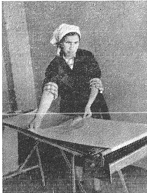
Рис. 26. Нанесение клейстера на обои при помощи ванночки, укрепленной на столике обойщика
