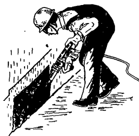
Рис. 69. Скальвание участка стеновой панели
