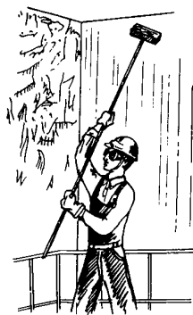
Рис. 71. Отбивка старого затирочного слоя
