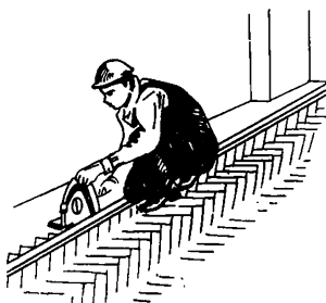
Рис. 83. Обрезка предфризового ряда
