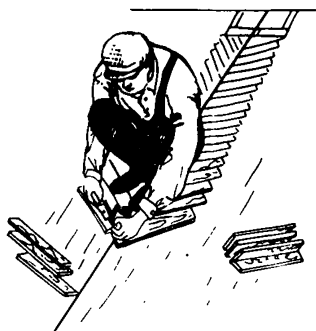
Рис. 81. Настилка маячной "елки"
