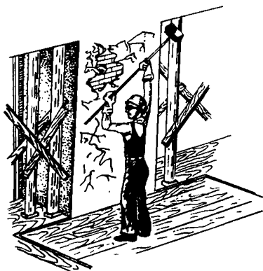
Рис. 33. Отбивка штукатурки на простенке
