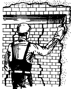
Рис. 14. Зачеканка зазоров между балкой и старой кладкой
