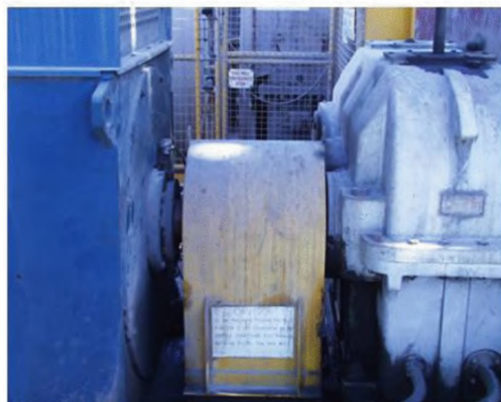
Рисунок С.3 – Двигатель и входной вал редуктора
