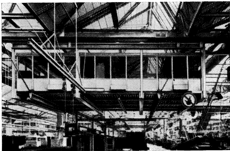
Рис. 17. Примеры объемных блоков внутрицеховых вспомогательных помещений а — блок цеховой конторы в автосборочном корпусе автозавода им. И. А. Лихачева в Москве (проектное управление ЗИЛ); б — подвесной блок конторы мастера в сборочном цехе автозавода (ФРГ)
