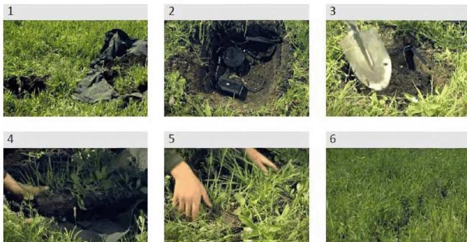
Рисунок 2.110- Последовательность установки РС-У
