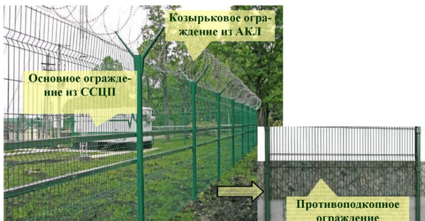
Рисунок 5 – Современный типовой вид заграждения периметра объекта (основное и противоподкопное из ССЦП, козырьковое из АКЛ)
