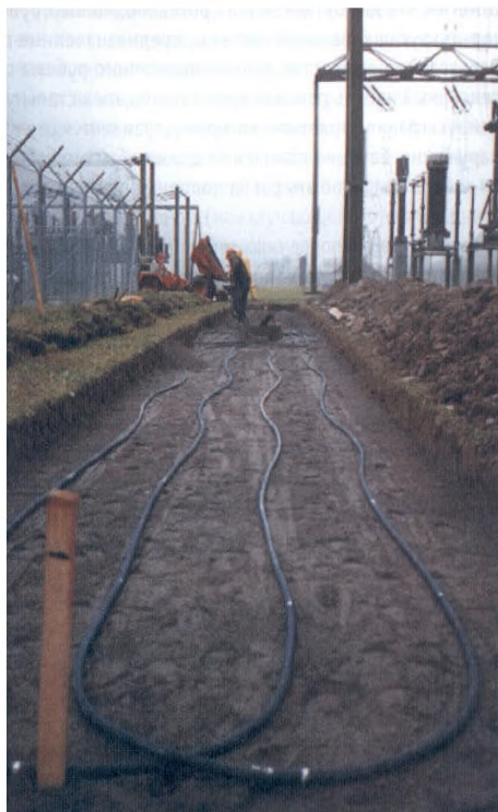
Рисунок 18 – Установка шлангов
