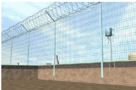
Рисунок 8 – Установка ЧЭ для определения подкопа
