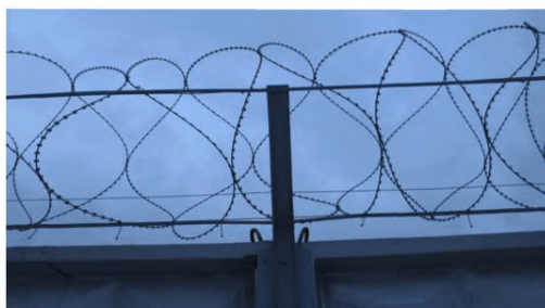
Рисунок 79 - Установка ЧЭ на АКЛ
