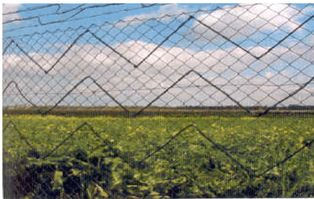
Рисунок 45 - Установка извещателя на сетке
