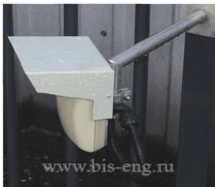
Рисунок 40 - Однопозиционный извещатель «Armidor»
