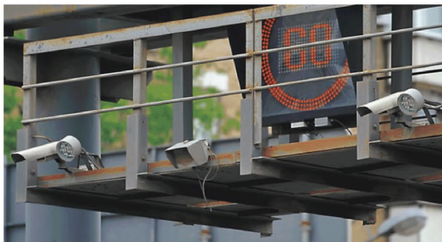
Рис. 51 - Размещения камер системы распознавания номеров на арке
