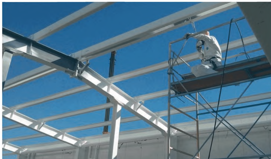
Рис. 1 Нанесение огнезащитных покрытий
