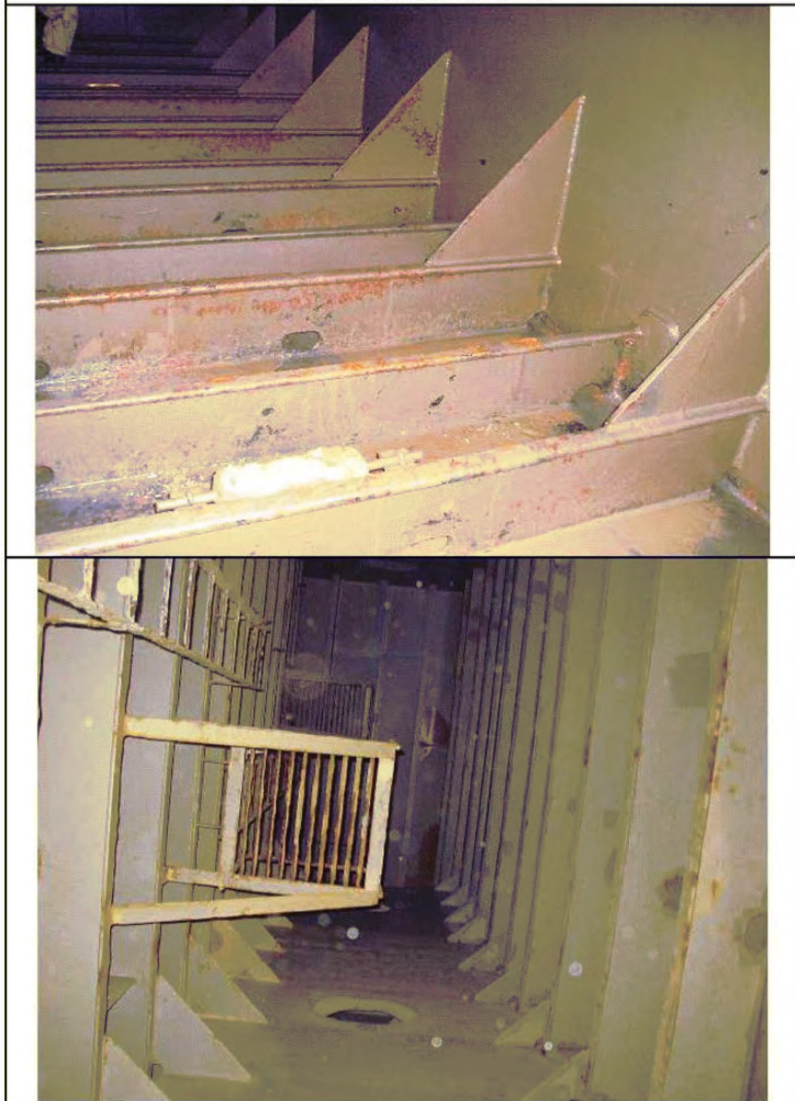
ХОРОШЕЕ СОСТОЯНИЕ ПОКРЫТИЯ
