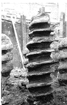
Рис. 8.15. Технология «Атлас»: а - тело свай в грунте; б - теряемый наконечник
