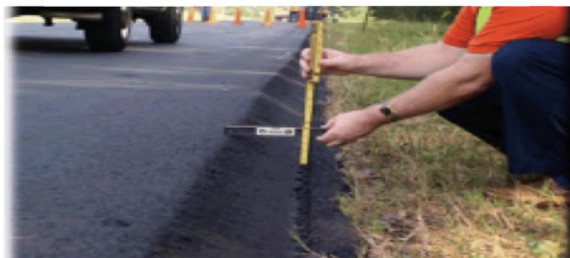
Рисунок 2 – Измерение толщины слоя по кромке
