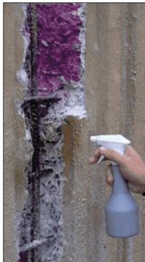
Рисунок 5 – Химический контроль: анализ глубины карбонизации с использованием индикаторного раствора фенолфталеина
