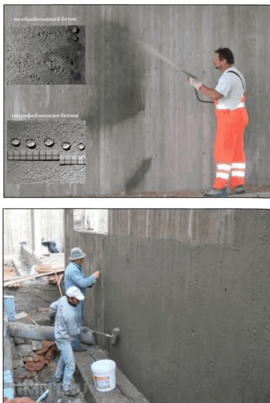
Рисунок 16 – Нанесение систем защитных покрытий
