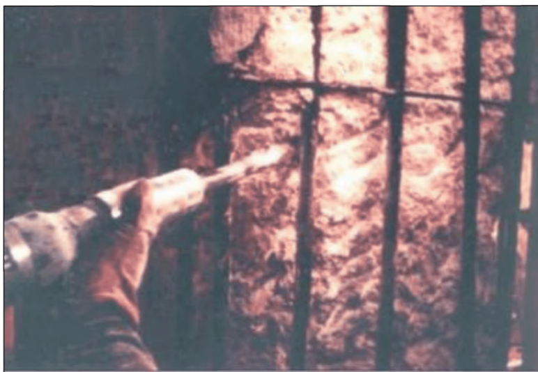
Рисунок 11 – Подготовка поверхности с помощью бучарды
