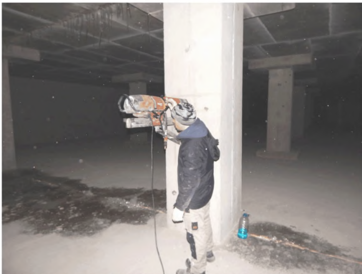
Фото 3 – Работы по отбору пробы бетона – керна из железобетонной конструкции
