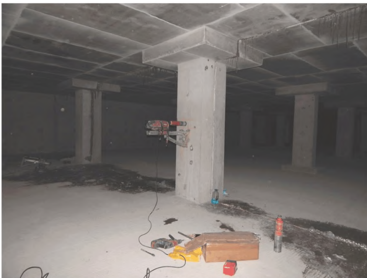
Фото 2 – Работы по отбору пробы бетона – керна из железобетонной конструкции
