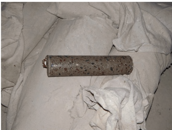
Фото 8 – Отобранная проба бетона - керн
