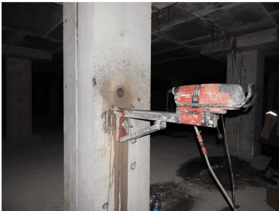
Фото 5 – Работы по отбору пробы бетона – керна из железобетонной конструкции
