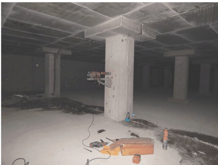
Фото 4 – Работы по отбору пробы бетона – керна из железобетонной конструкции
