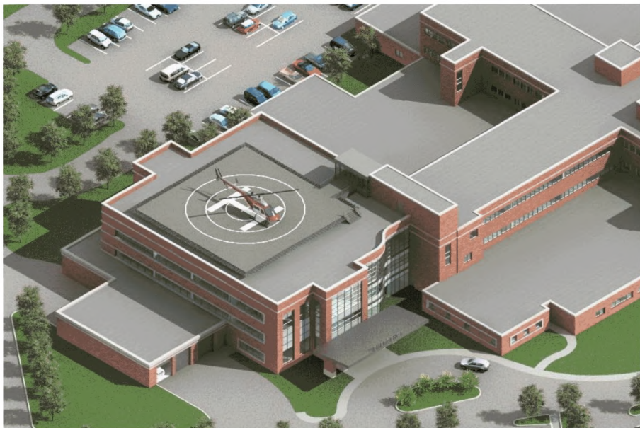
Рисунок 30 – Вертолетная площадка на кровле здания
