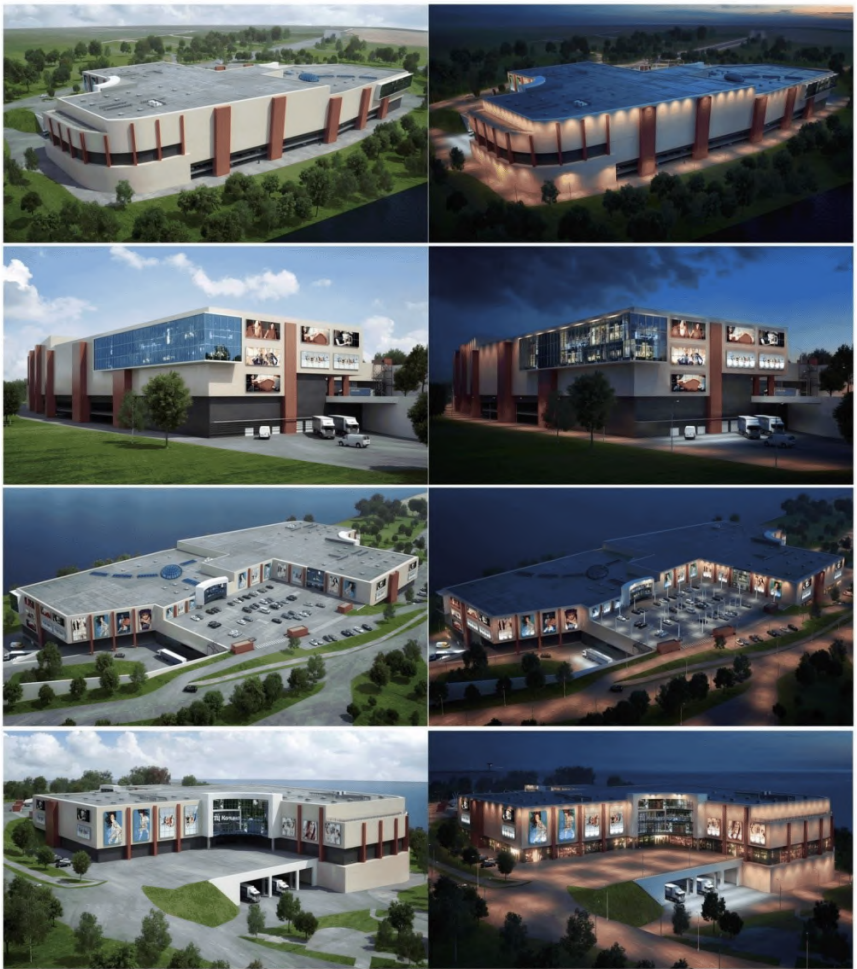
Рисунок 39 – Пример размещения многофункционального здания с учетом устройства подъездов и проездов для пожарных автомобилей
