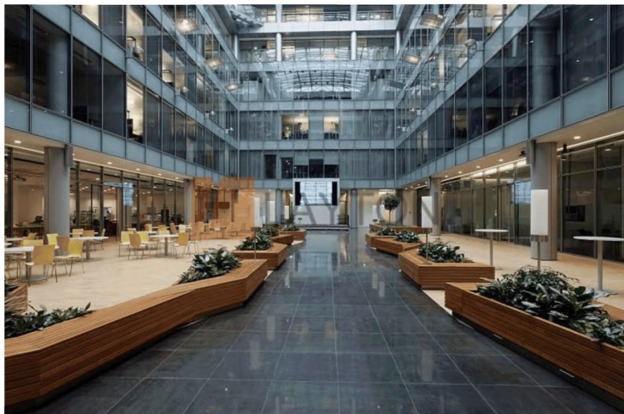
Рисунок 12 – Пример проектного решения по отделению атриумного пространства от примыкающих коридоров и галерей светопрозрачными перегородками
