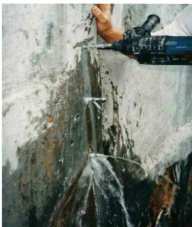
Рисунок 5 – Установка иньекторов
