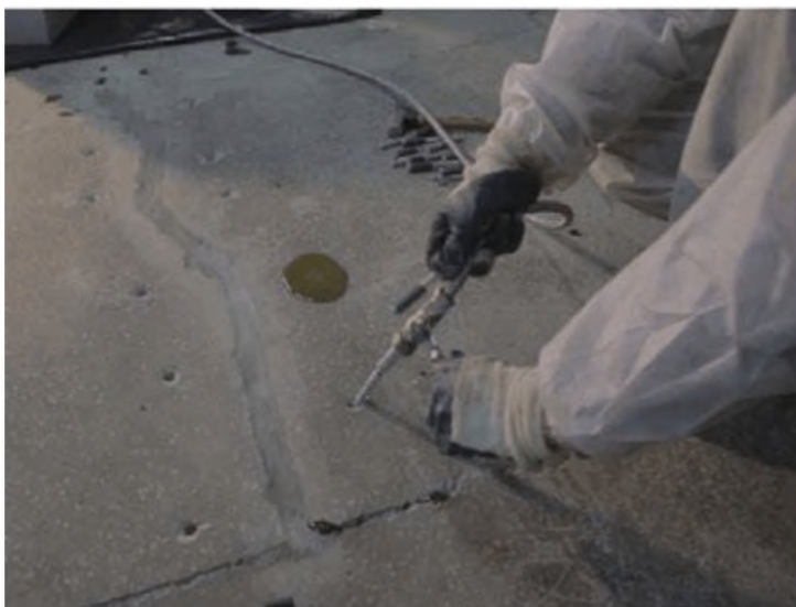
Рисунок 4 – Выполнение инъекционных работ
