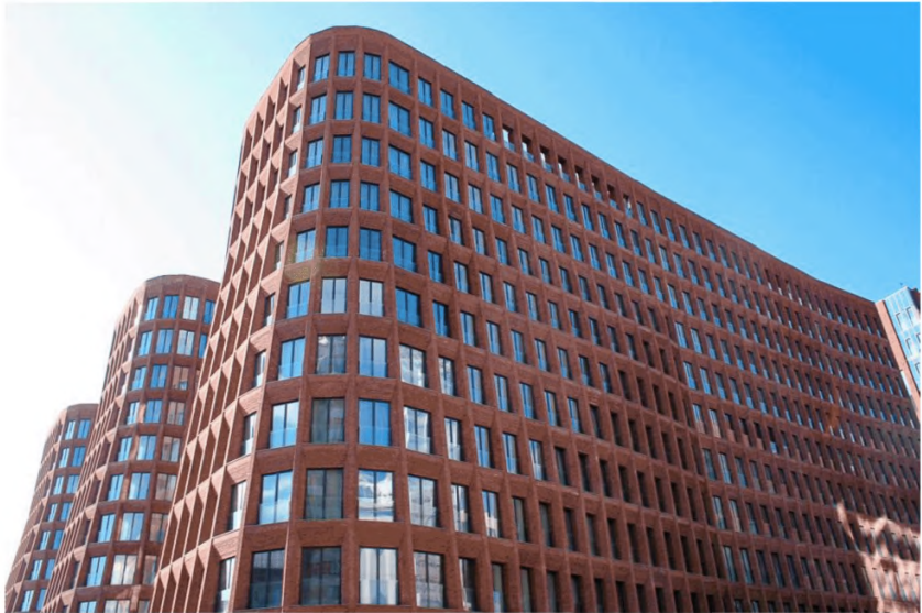
Рисунок А.1а – Общий вид конструкции фасадов зданий с облицовкой из кирпича жилого комплекса «Садовые кварталы» (взято из открытых источников Internet)
