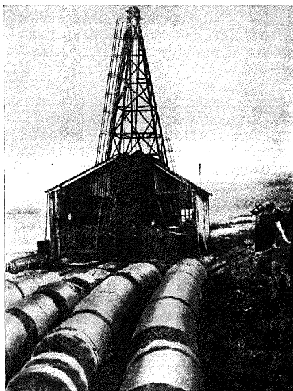
Рис. 5-21. Бурение смотровой скважины. На первом плане керн.
