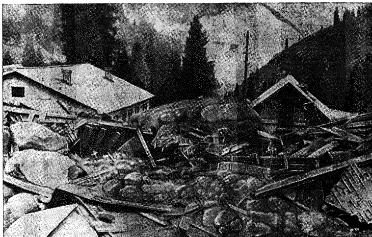
Рис. 3-21. Разрушение селем построек турбазы.
