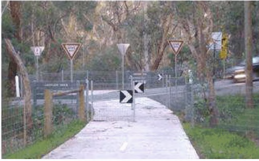
Рисунок 3.6. Примеры ограничения доступа автомобильного транспорта на велодорожку
