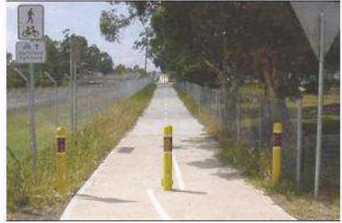
Рисунок 3.6. Примеры ограничения доступа автомобильного транспорта на велодорожку
