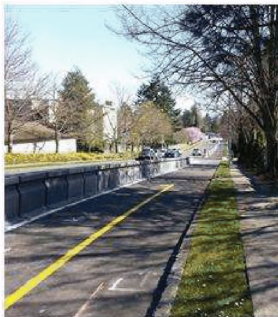
Рисунок 3.8. Пример установки защитного барьера для отделения велополосы от проезжей части автомобильной дороги
