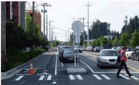
Рисунок 3.13. Пример отделения велополосы от проезжей части
