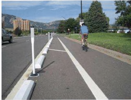
Рисунок 3.12. Пример разделительной полосы переносными конструкциями
