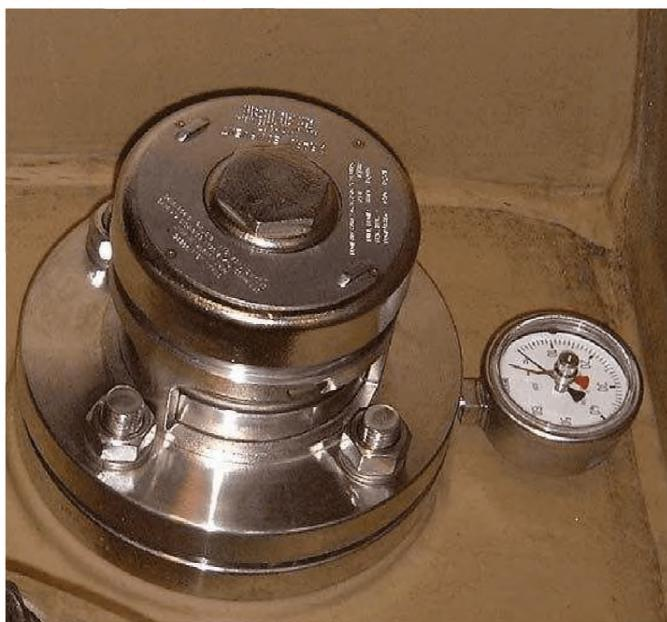
Рис. 8.1 Типичный предохранительный клапан с манометром
