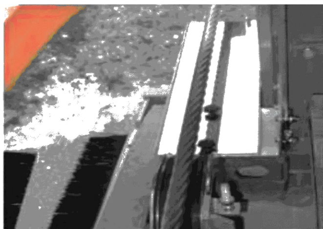
Рисунок А.15 — Проверка состояния каната с использованием зеркала при визуальном-измерительном контроле
