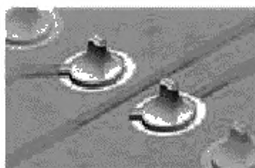
Рисунок 5 с — Удаление покрытия завершено
