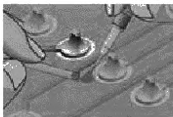
Рисунок 3 б — Удаление отвержденного покрытия с обрабатываемого участка
