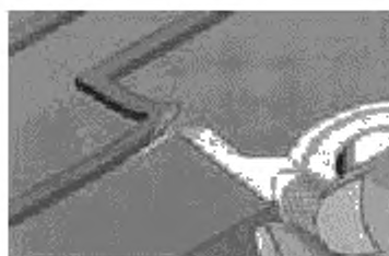
Рисунок 17 а — Нанесение эпоксидного состава под отслоившийся проводник
