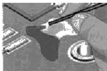
Рисунок 9 d — Создание текстуры поверхности пористым тампоном
